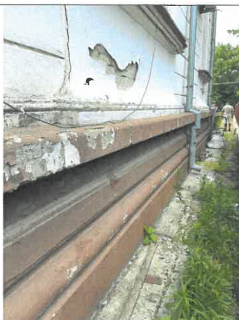
Fig. 4 – Degradari soclu si tencuiala
