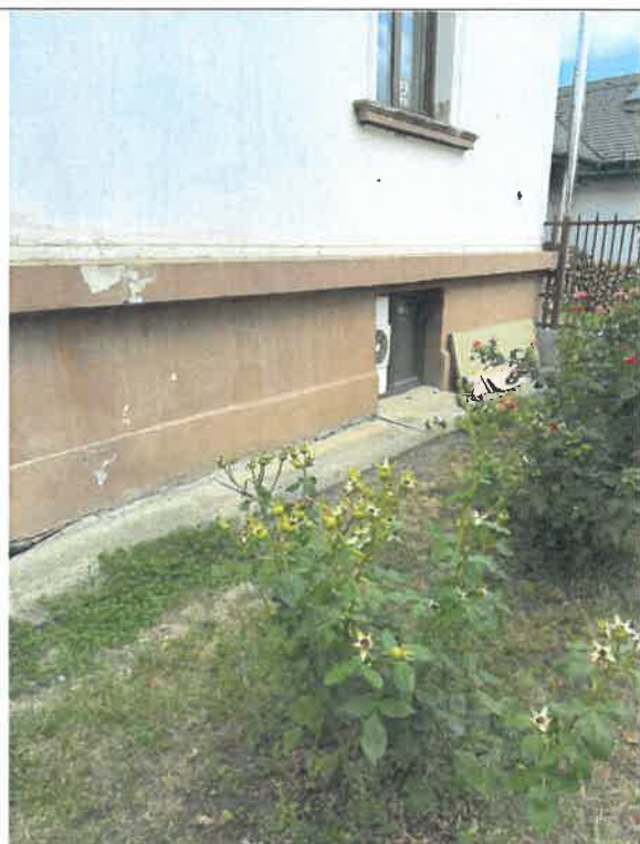
Fig. 2 Degradari soclu
