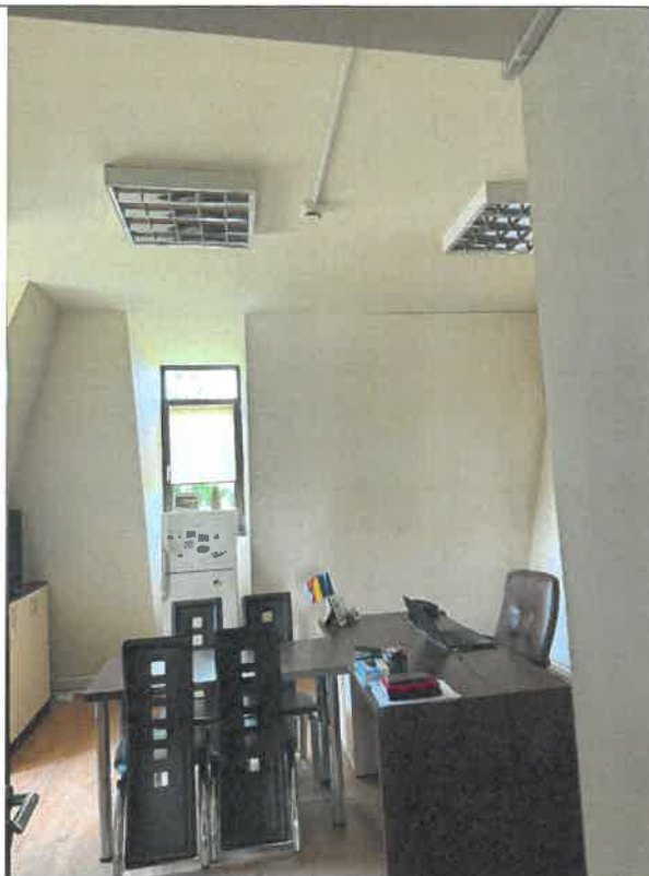
Fig. 9 – Etaj mansardat- structura este inchisa cu gips-carton
