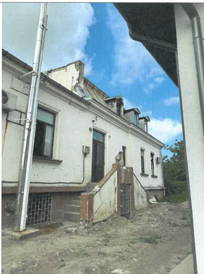
Fig. 3 – Fisuri majore in scari exterioare. Timpan zidarie degradat. Tabla acoperis degradata
