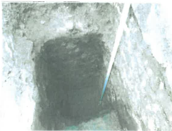
Decopertare a fundației
